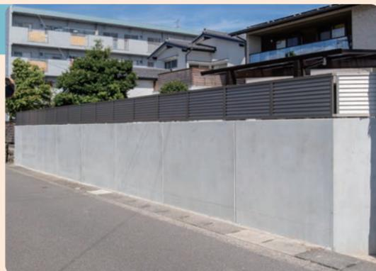
「塀のねっこ」は厚く強靱な鉄筋コンクリート構造を活かし、簡易的ではありますがガードレールの機能を持っています。
