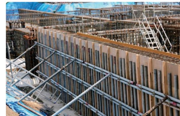
組上げるのに大きな手間の掛かる現場打ち型枠。型枠の孕みを抑える補強がわかる。
