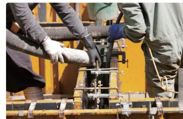
天候・気温に大きく影響される現場打ちコンクリート。ポンプ車による打設風景。
